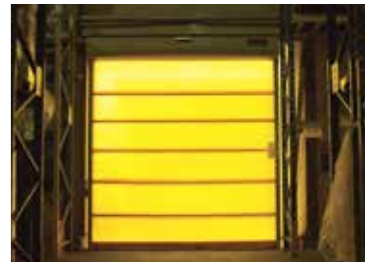
名張営業所の倉庫 倉庫内では、医薬品関係の荷を取り扱っているため、虫が入らないようセンサー付きの特殊なシャッターが使用されている。下の写真は、シャッター内側の倉庫内
