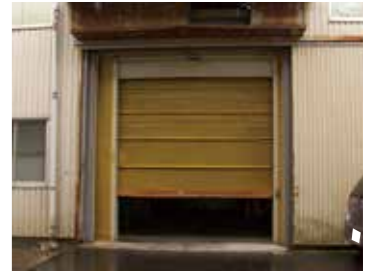
名張営業所の倉庫 倉庫内では、医薬品関係の荷を取り扱っているため、虫が入らないようセンサー付きの特殊なシャッターが使用されている。下の写真は、シャッター内側の倉庫内
